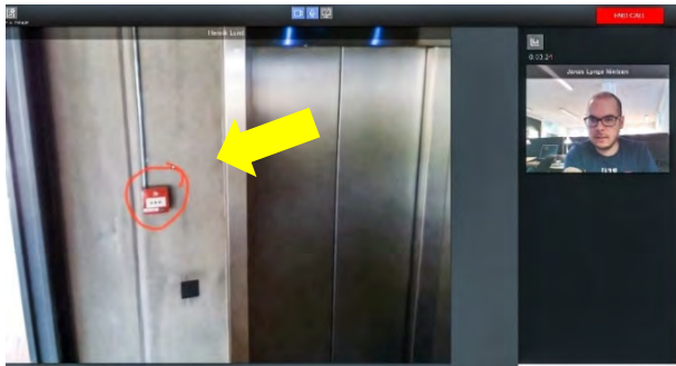
Kommunikation med projektleder set gennem brillen. Lig mærke til den røde cirkel omkring brandalarmen som projektlederen har indtegnet fra sin computer.
